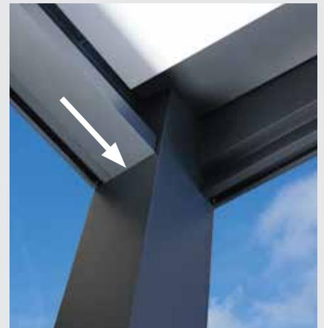
Wasserablenkung über Rinne direkt in Stützpfosten
